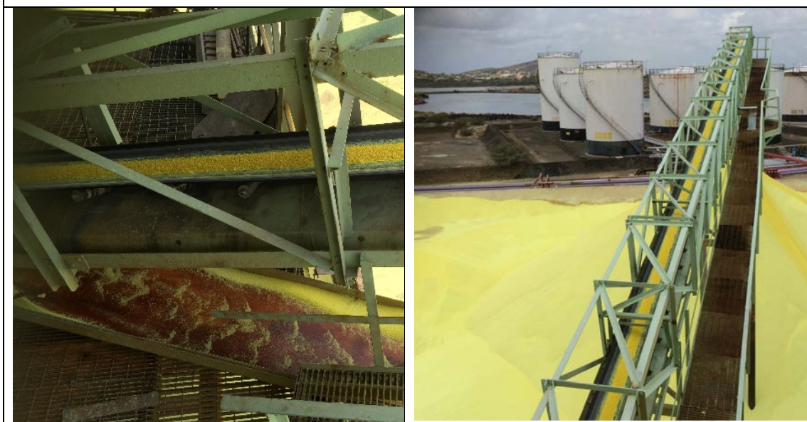
Afbeelding 5.3: In de pelletizer wordt de vloeibare zwavel in water afgekoeld tot kleine bolletjes die worden opgeslagen op het open terrein in afwachting van verscheping.
