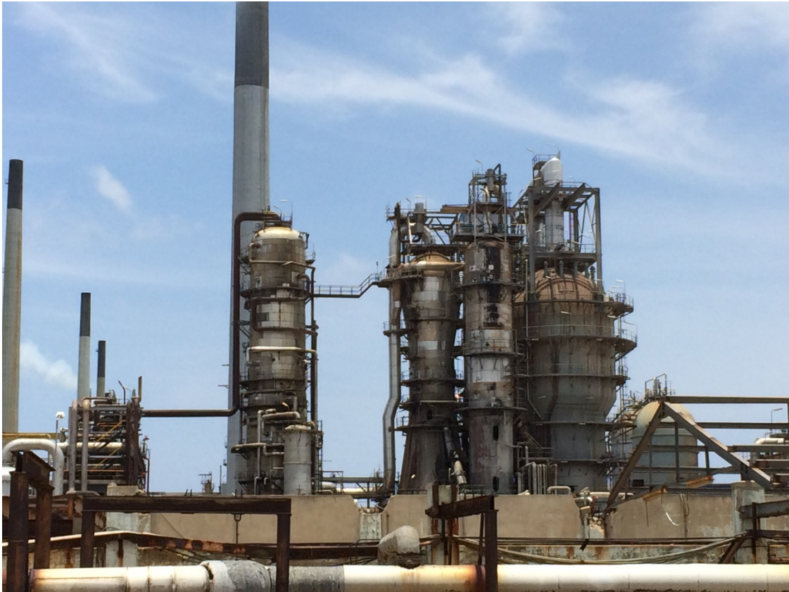
Afbeelding 7.2: De FCCU van de ISLA raffinaderij
