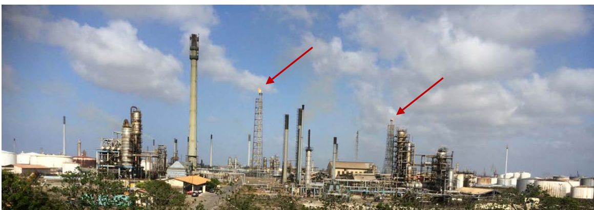
Afbeelding 8.1: twee torenfakkels waar op grote hoogte gas wordt verbrand
