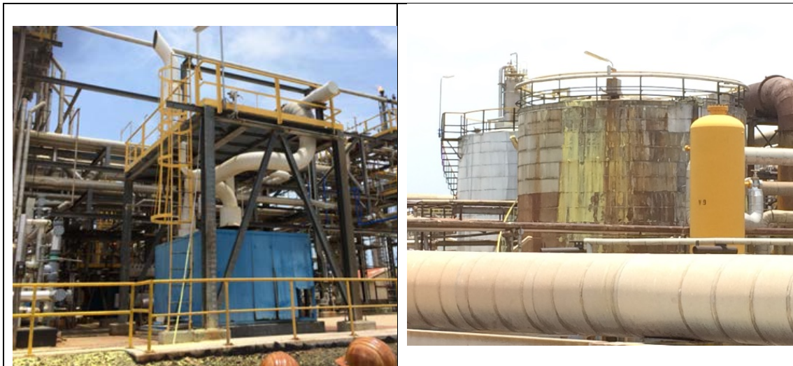
Afbeelding 5.2: Een zwavelterugwinningseenheid (SRU) en opslagtanks voor vloeibare zwavel
