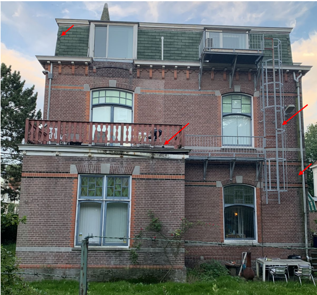
Foto 5: Achteruitgang aan het schilderwerk, losse 'shingles', niet functionerende brandtrap en schimmelvorming aan de muur
