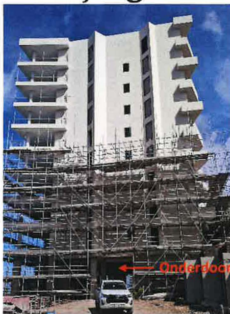
Fotografische vastlegging flatgebouw 6
