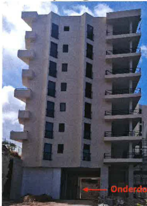
Fotografische vastlegging flatgebouw 5
