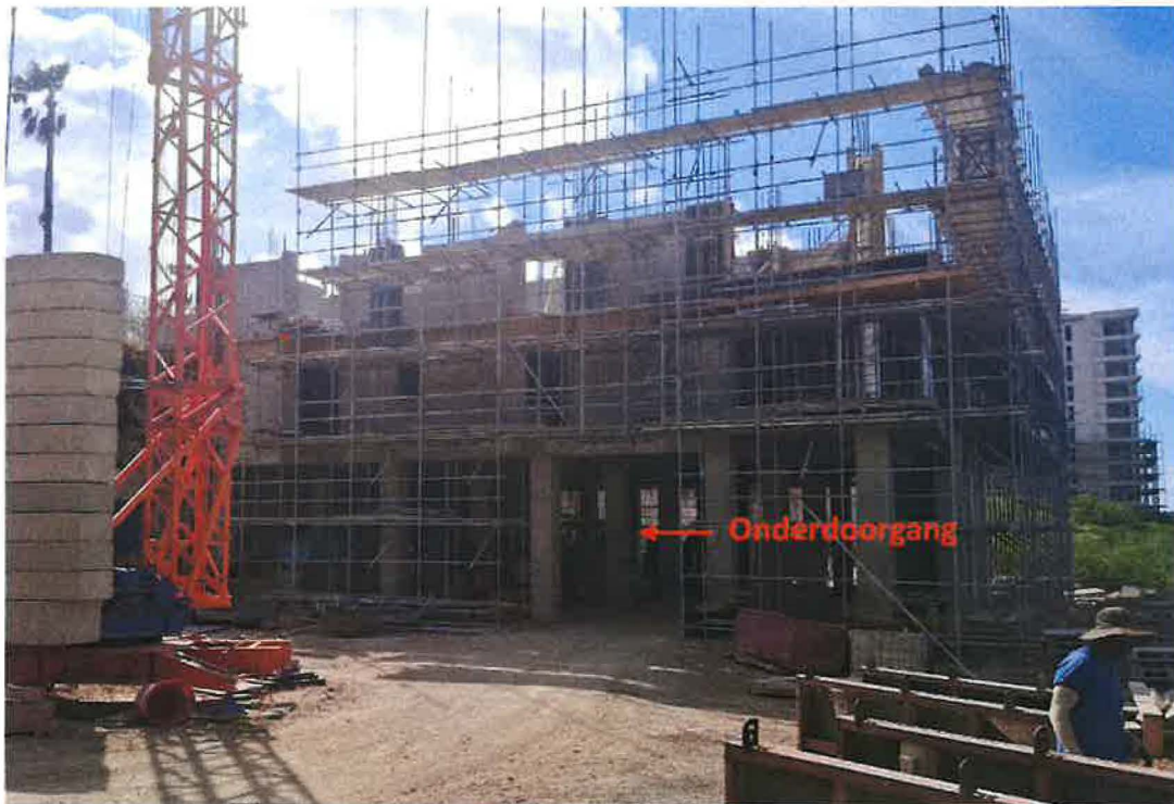
Fotografische vastlegging flatgebouw 4, in aanbouw
