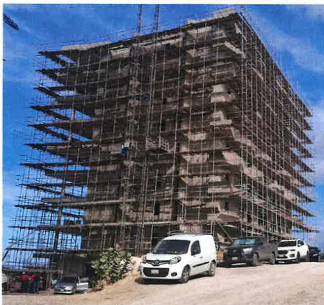
Fotografische vastlegging flatgebouw 2
