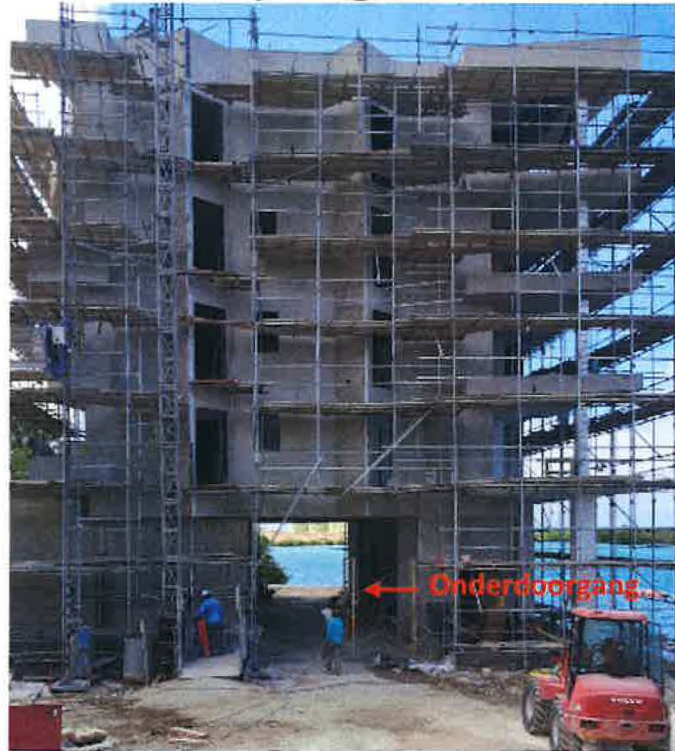
Fotografische vastlegging flatgebouw 8
