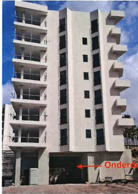
Fotografische vastlegging flatgebouw 7
