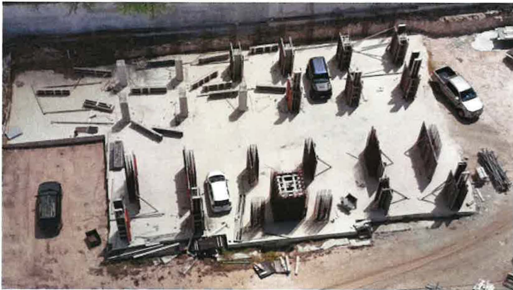
Fotografische vastlegging flatgebouw 1, in aanbouw, begane grondvloer
