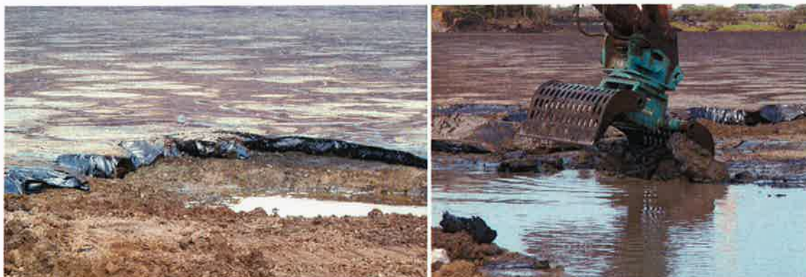
Afbeelding 7.6: De laag asphalt die wordt afgegraven door Asphalt Lake Recovery
